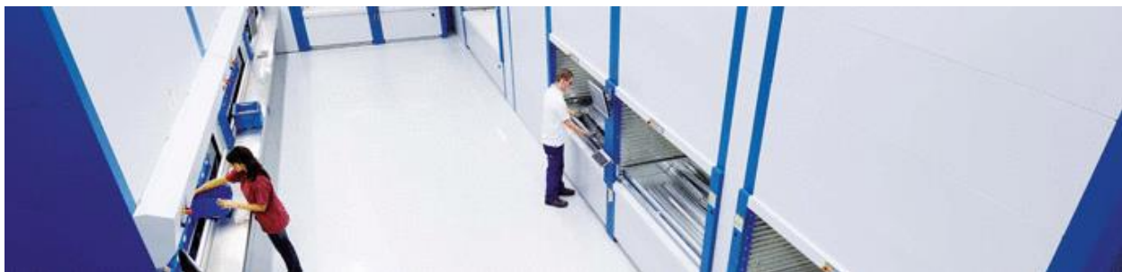
Рис. 2. Автоматизированные системы хранения
